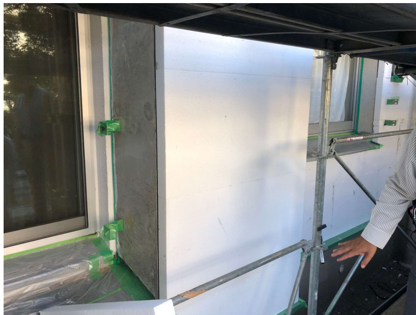
外断熱施工風景
