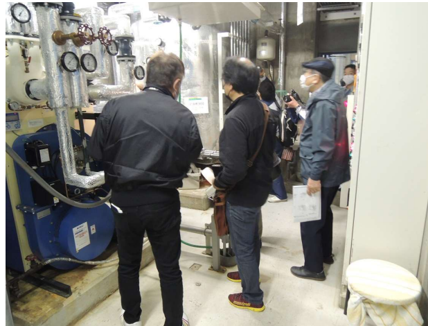
機械室内 調査風景
