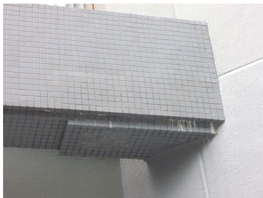
外部 外壁 低層部タイル貼
